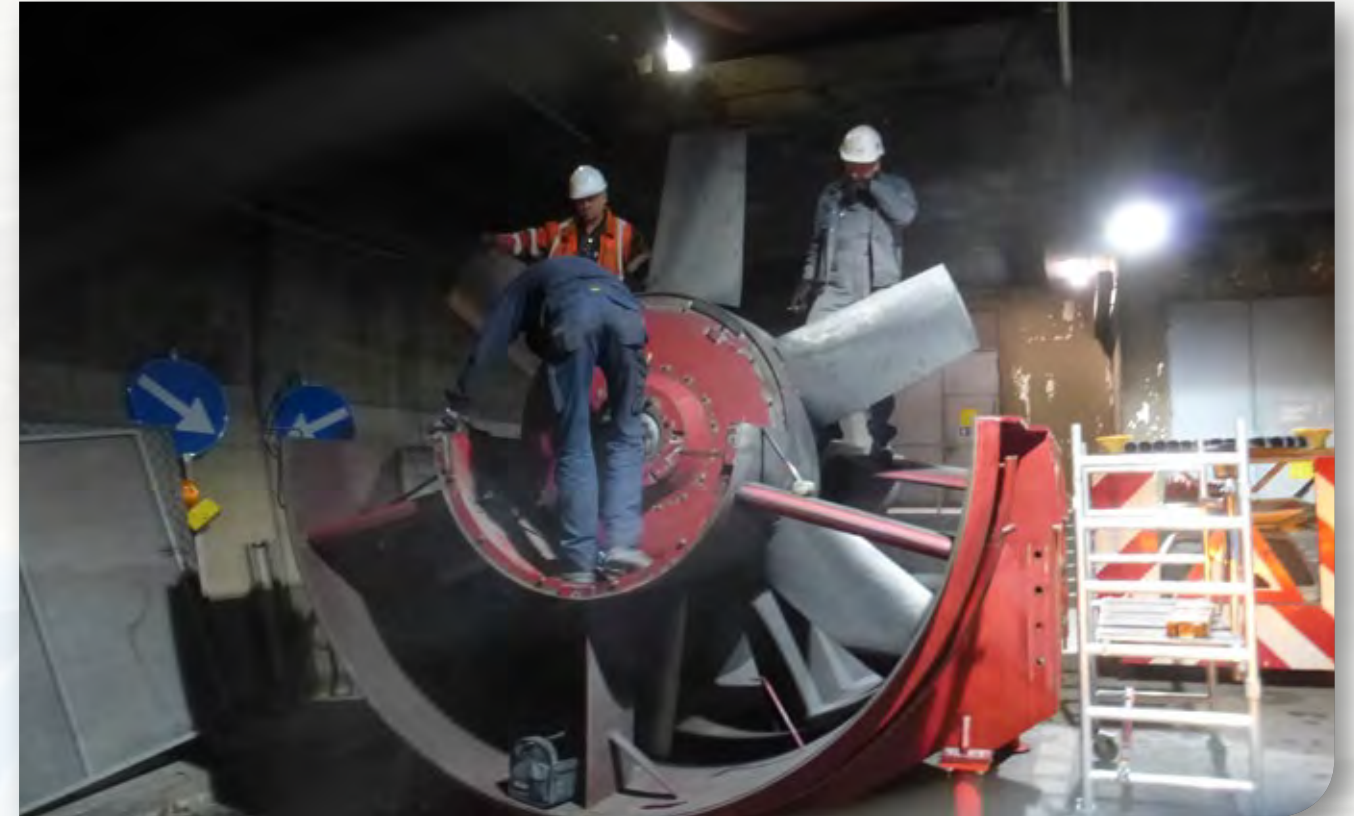
Demontage Ventilator-Motor-Einheit im Tunnel
