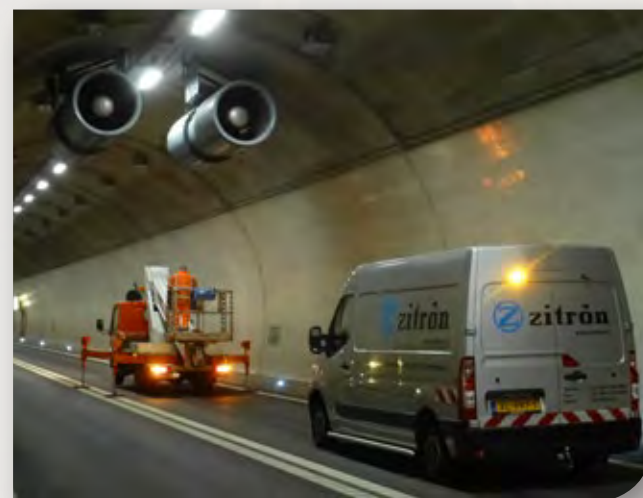
Tunnel Raimeux - Moutier, Schweiz
