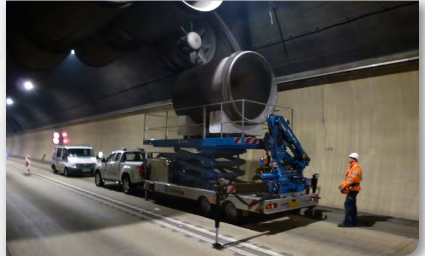
Demontage Strahlventilator im Tunnel
