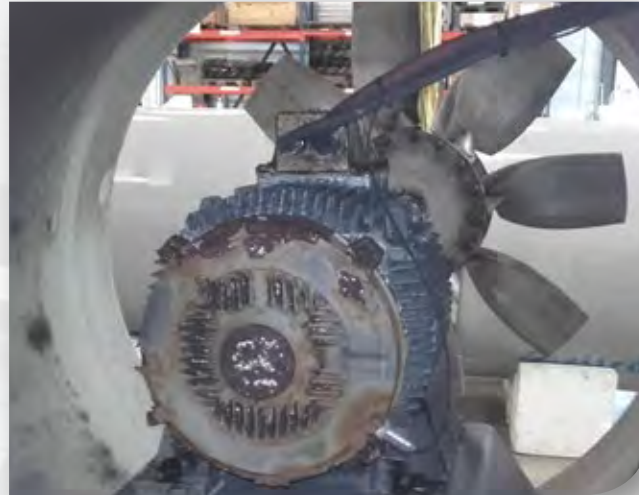
Demontage Strahlventilator für Überholung
