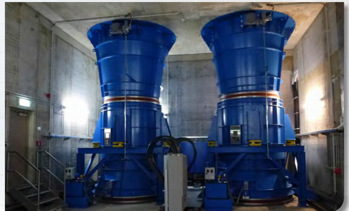
Tunnel Gernsbach - Gernsbach, Deutschland
