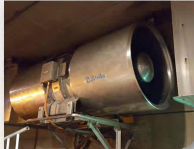
Bosrucktunnel - Ardning, Österreich
