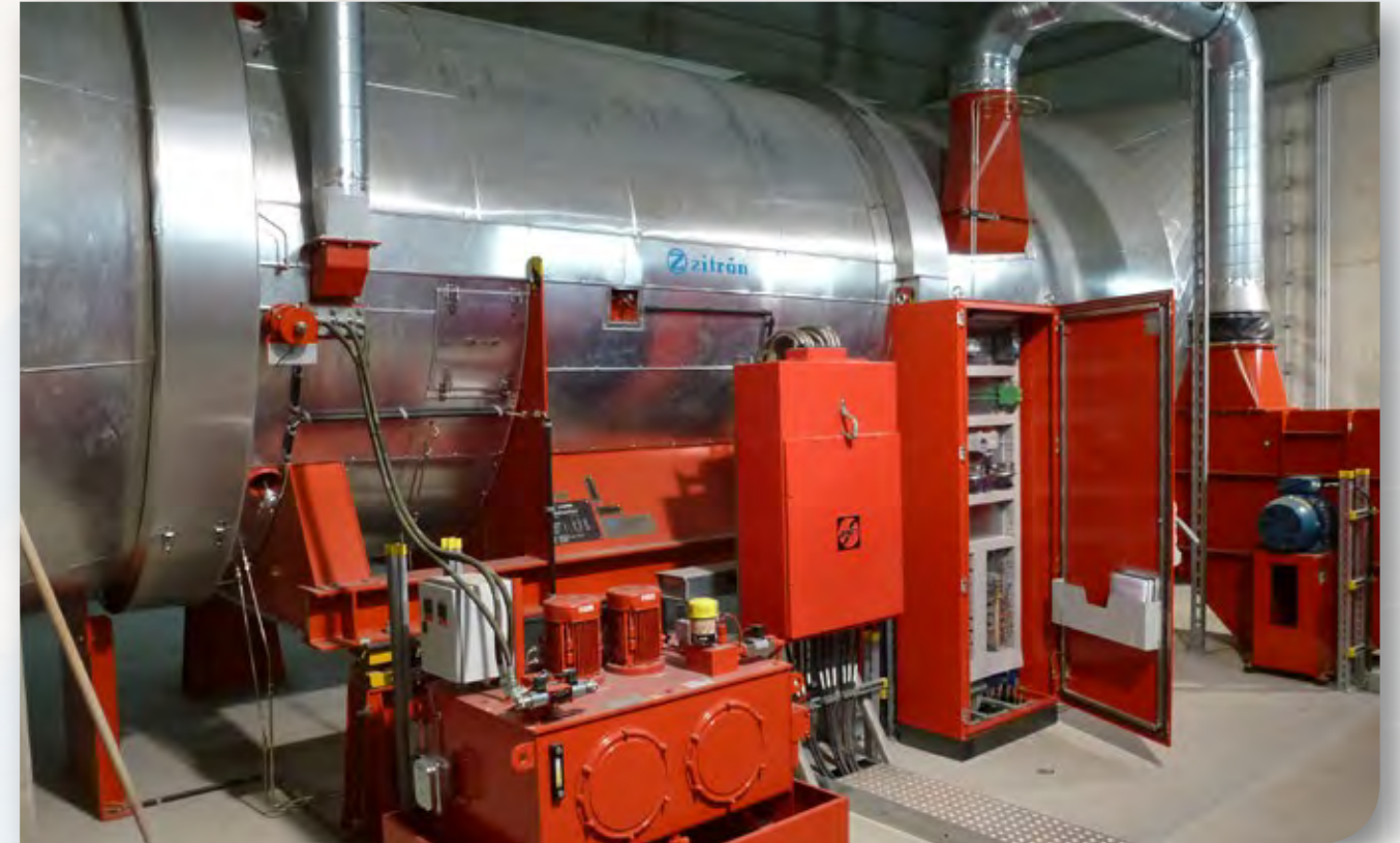
Bosruckstunnel - Ardning, Österreich
