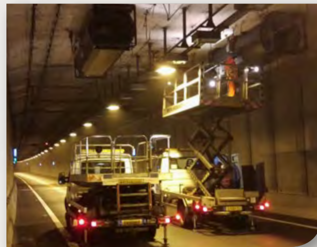
Tunnel Swalmen - Swalmen, Niederlande
