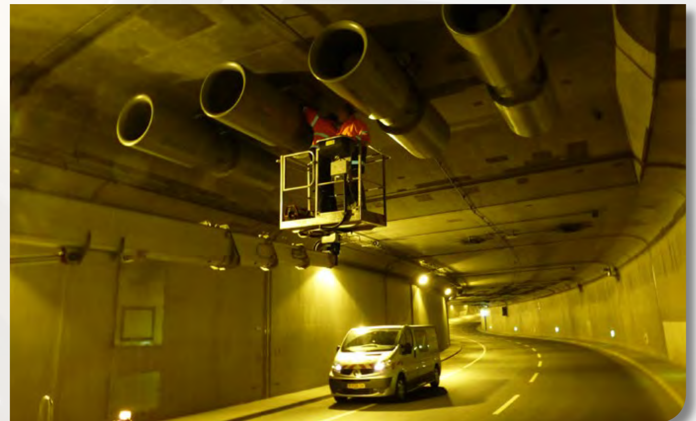
Tunnel Tiergarten - Berlin, Deutschland
